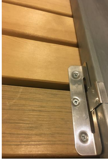
Hareketli klipsler ahşap alt yapıdan bağımsız çalışır.
