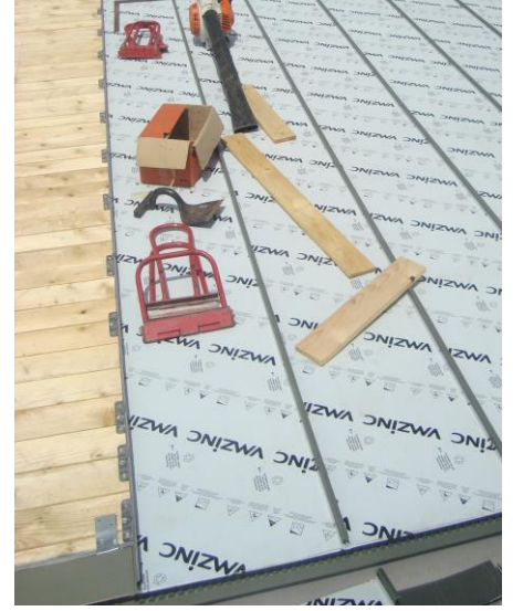
Hareketli klipsler saçak ucunda daha sık kullanılmalıdır.
