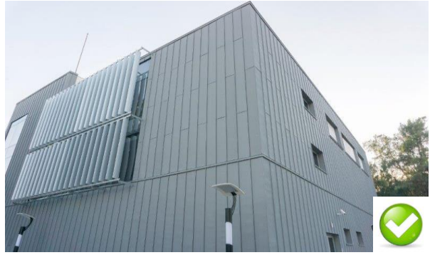
Farklı cephelerde aynı lot'lardan üretim yapılmış paneller
