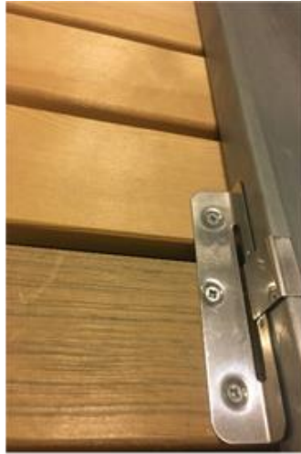
Hareketli klipsler ahşap alt yapıdan bağımsız çalışır.
