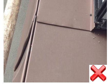
Bini hatası, çekiç darbeleri ve direk çinkoya vidalama sonucu kusurlu imalat.
