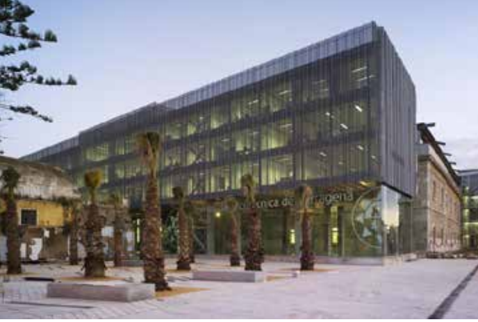
VMZ Perfore panel, özel bükümlü ve delikli ikincil cephe, QUARTZ-ZINC®
