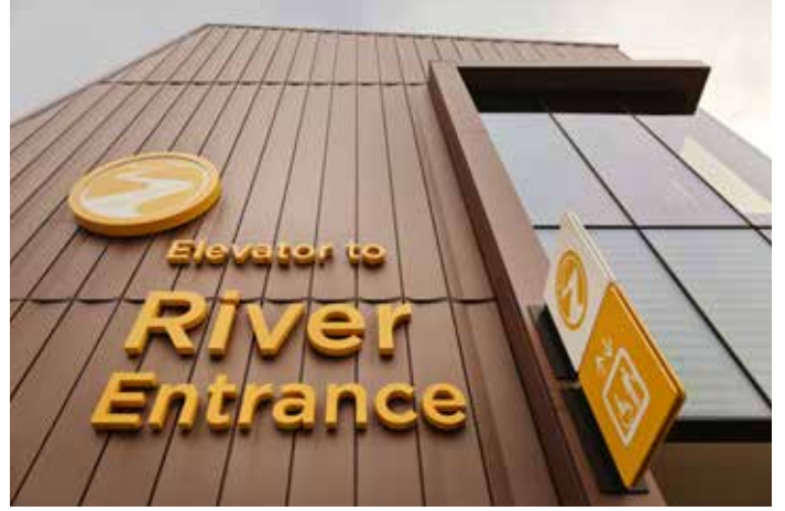
VMZ Interlocking, açılı özel büküm, PIGMENTO® Ağaçkabuğu
