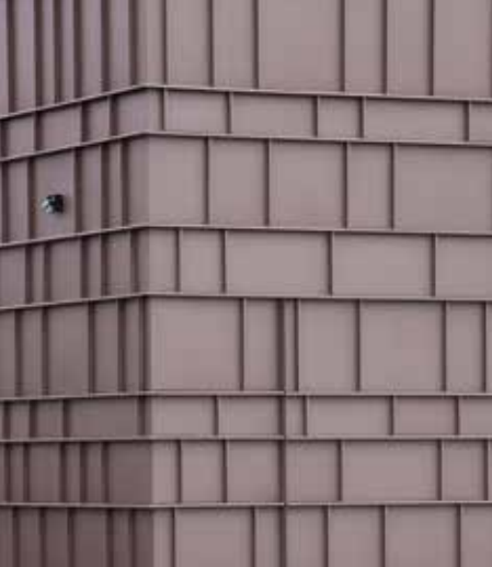
Düşey, yatay ve şaşırtmalı kenetler
