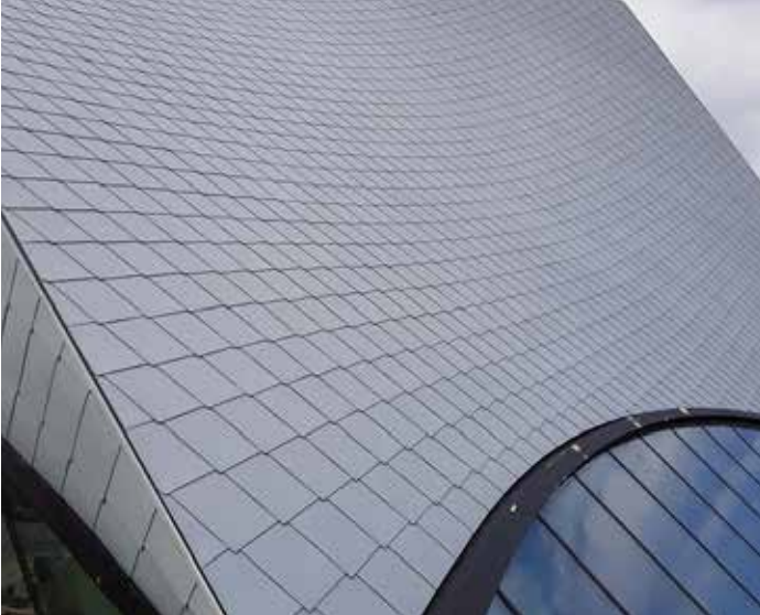
VMZ Düz Kilit (Pul Kaplama) Sistem
