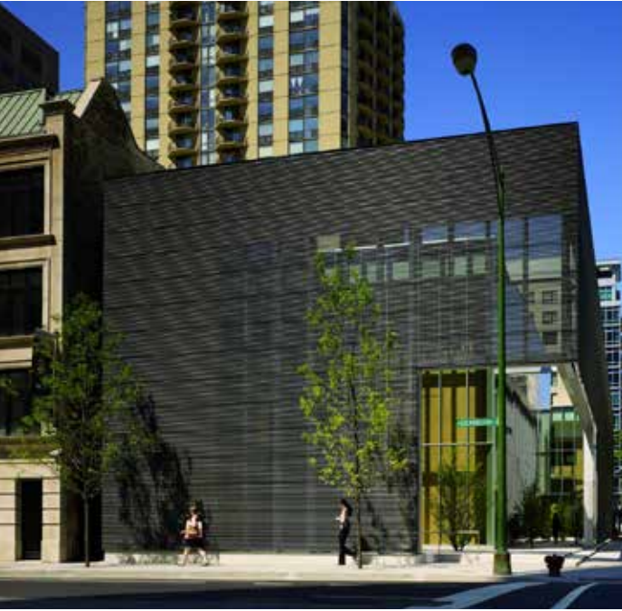
VMZ Sinüs dalgalı profil, perfore güneş kırıcı, ANTHRA-ZINC®
